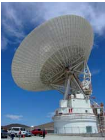
Рис. 1.3.3. Бистатическая РЛС Голдстоун. Передающая и приемная антенны
